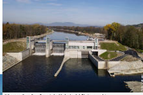
Wasser (Laufkraftwerk in Koltschitz / Steiermark)
