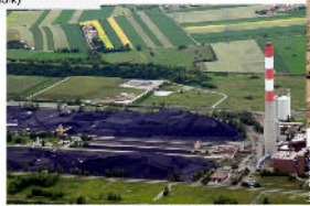
Kohle (Steinkohle-Kraftwerk in Dürnrohr / Oberösterreich)
