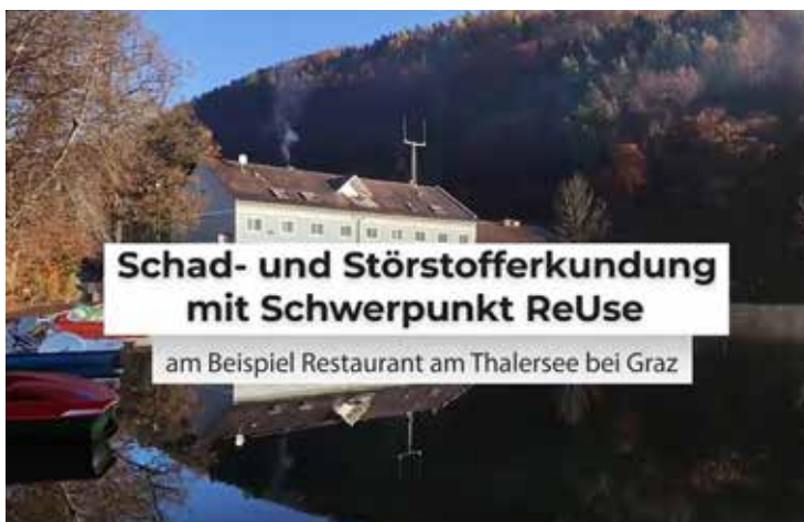
Abb. 9: Schad- und Störstofferkundung mit Schwerpunkt ReUse am Beispiel Restaurant am Thalersee bei Graz Bildquelle: Land Steiermark
